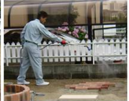
(6) 雑草アタックSの締固め作業
