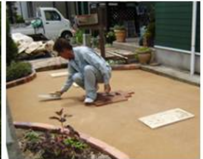
(6) 雑草アタックSの締固め作業
